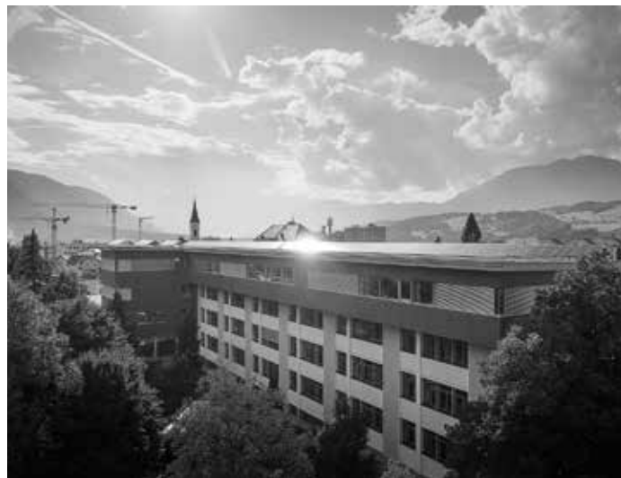
PV Anlage am Dach der Volksschule Wörgl
