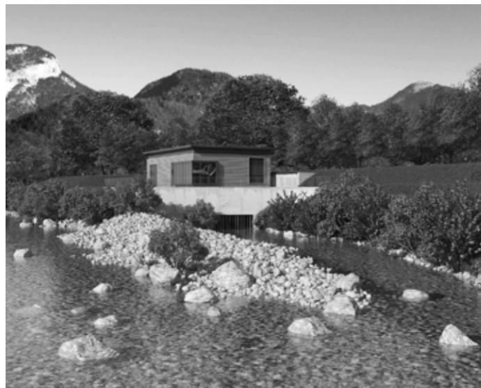
Geplantes Maschinenhaus mit Unterwassergerinne beim Kraftwerk Egerndorf
